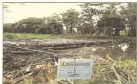
Gambar 13 Sekat Kanal menggunakan Material Gambut yang Dipadatkan
