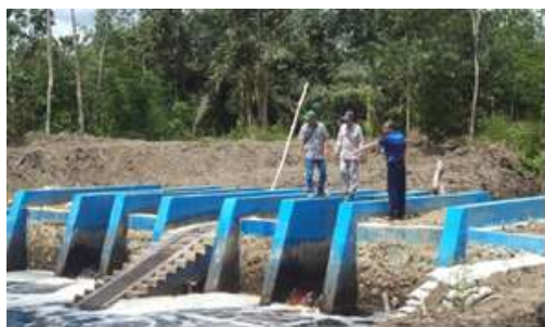
Gambar 14 Konstruksi Permanen Menggunakan Material Beton (CP3)
