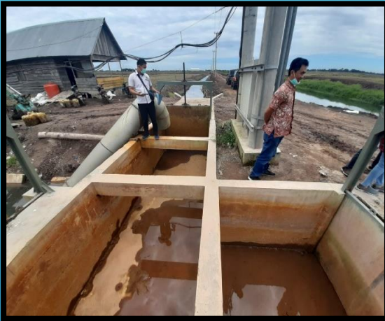
Bangunan bagi dan pintu air
