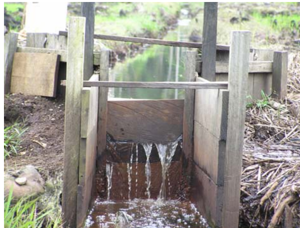
Gambar 10. Pintu air tradisional untuk mengatur tinggi muka air.
