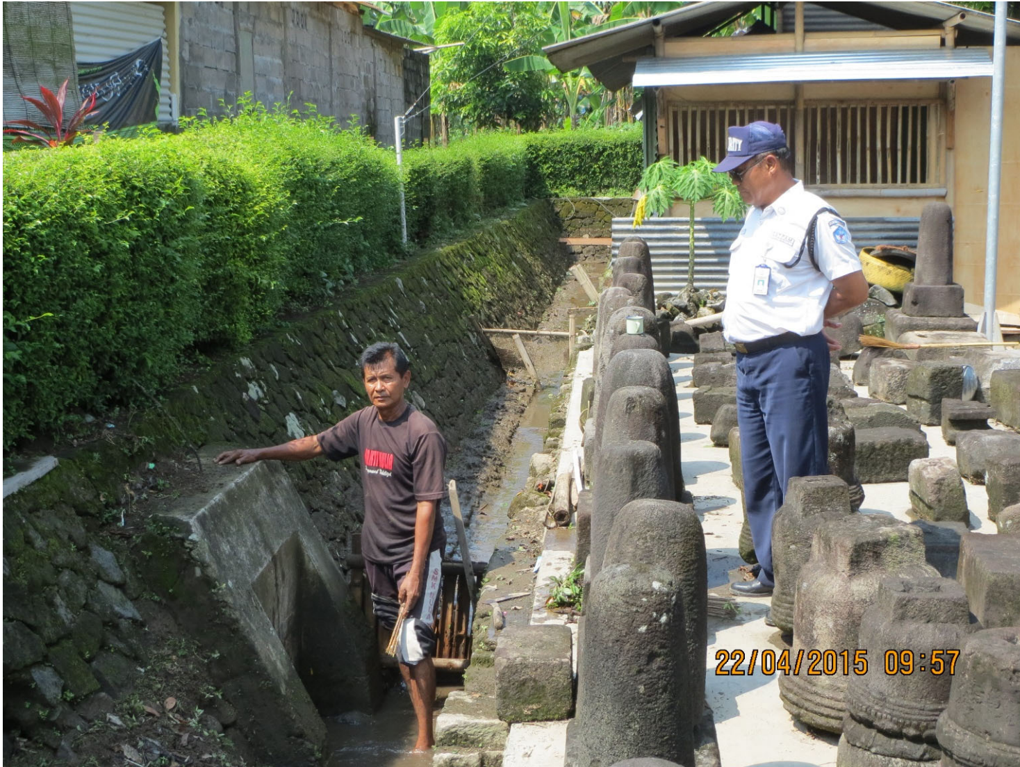
Outlet saluran drainasi keliling (sebelah timur candi).
