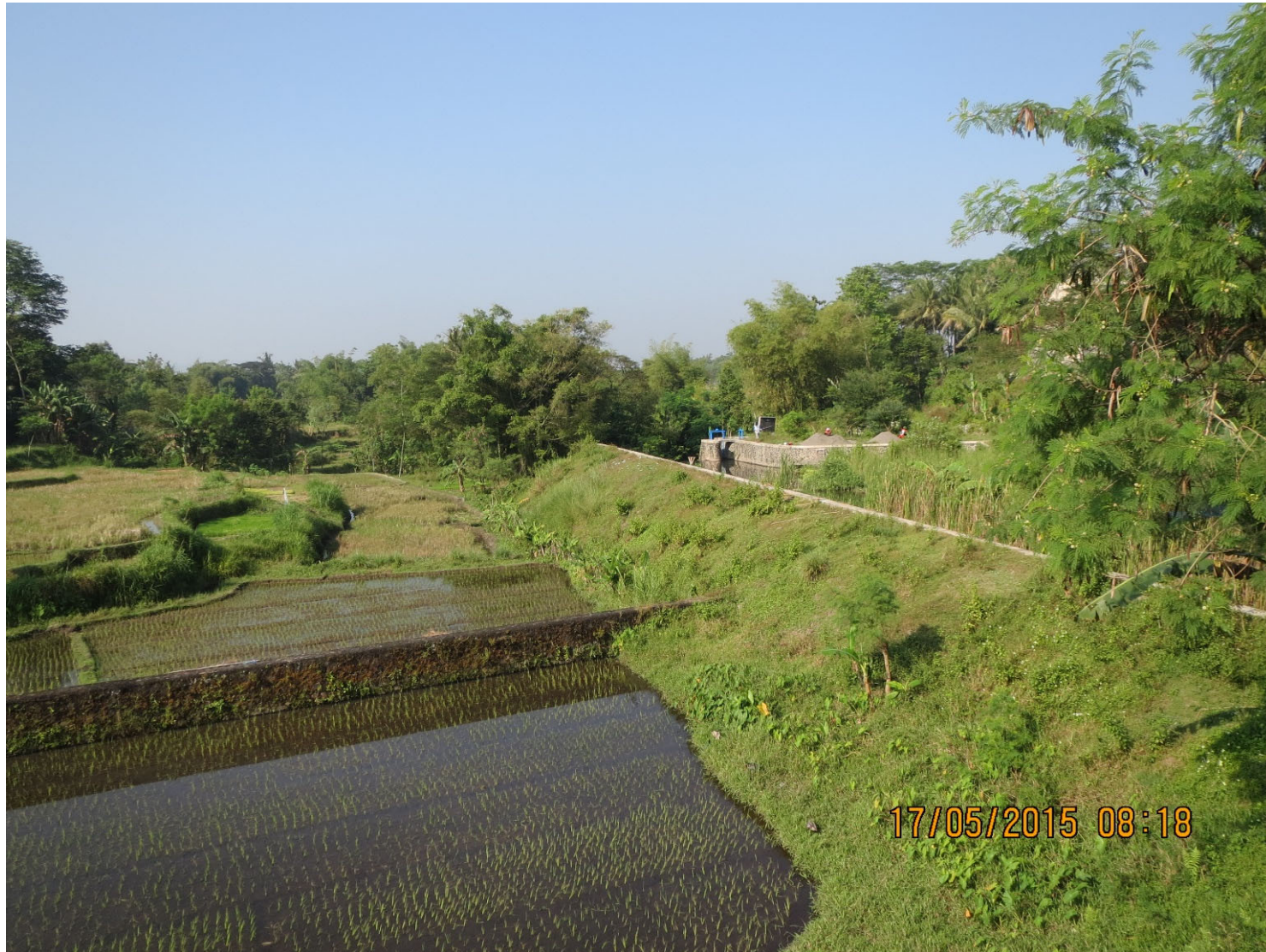
Bendung dan saluran irigasi yang merupakan outlet pembuang saluran drainasi keliling candi.
