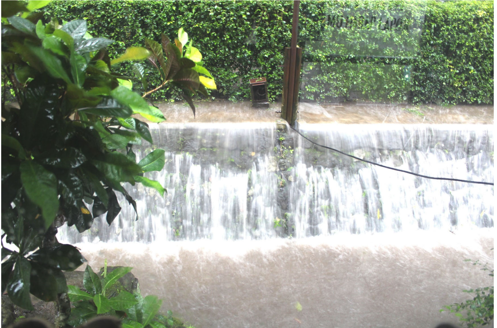
Saluran irigasi yang meluber ke saluran drainasi keliling (sebelah timur candi).
