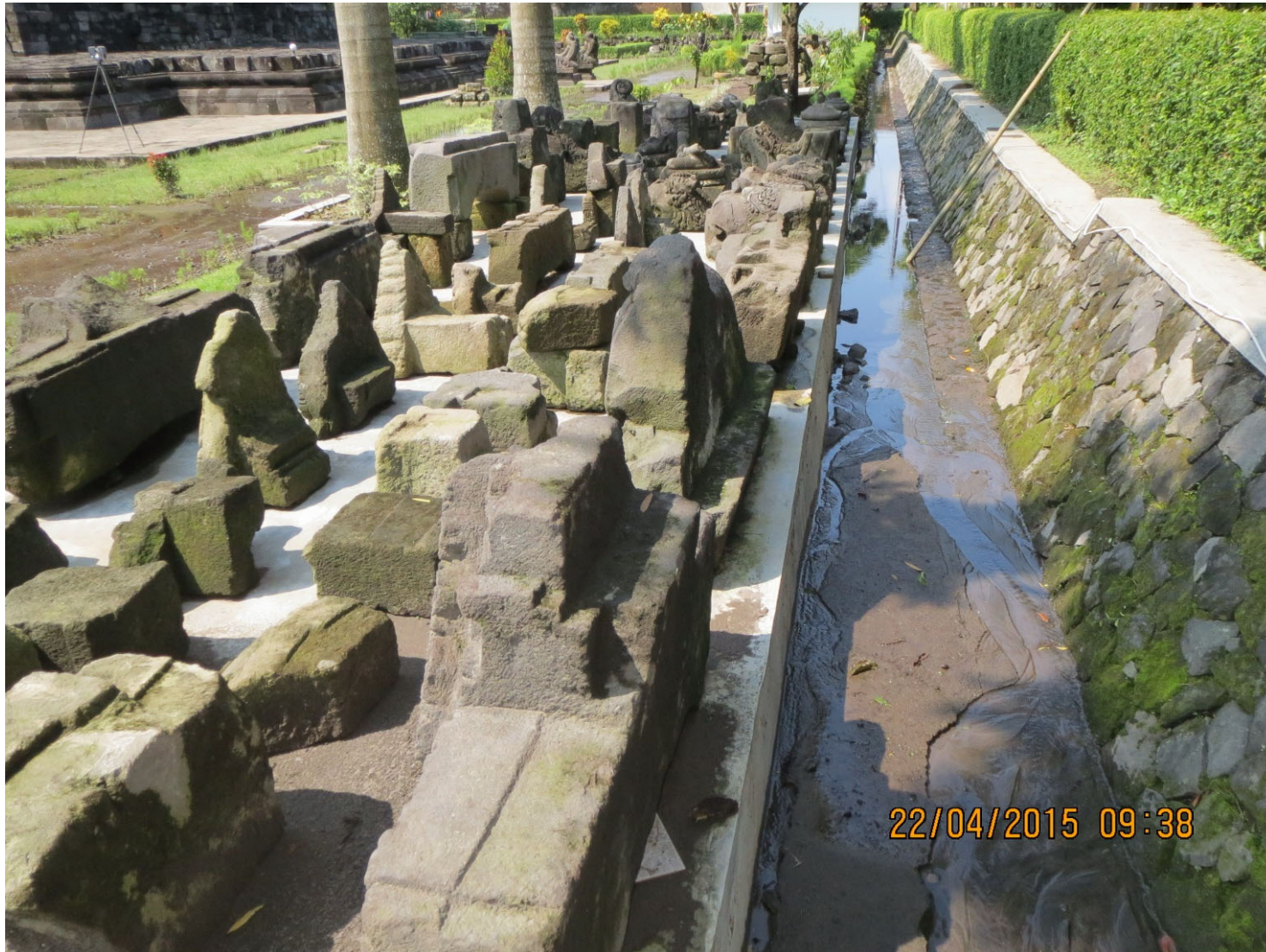
Saluran drainasi keliling (sebelah barat candi).
