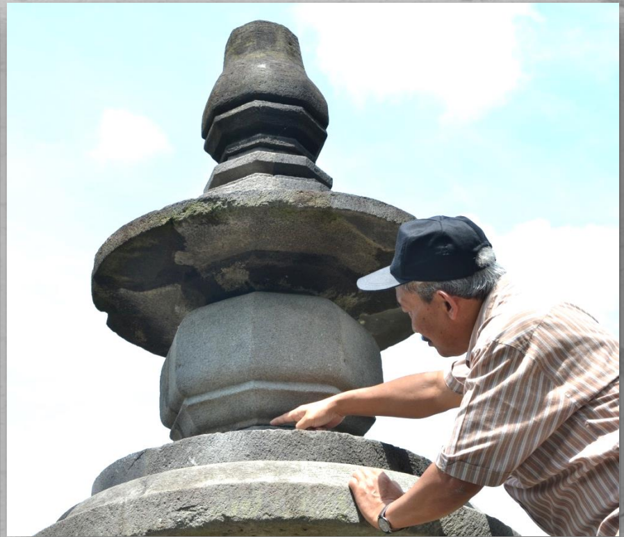
PENGAMATAN 2011: Profil 4, tidak lengkap, sambungan tidak cocok
