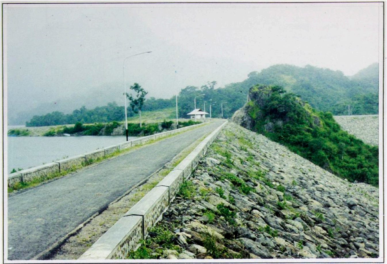
Situasi bendungan Tiu Kulit
