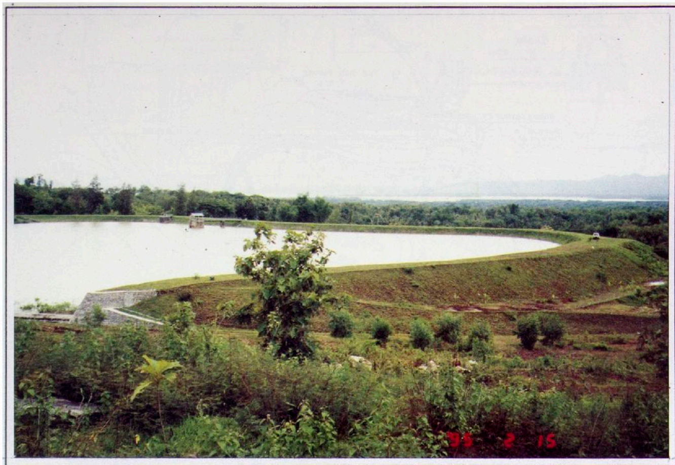
Situasi bendungan Plumbon,
