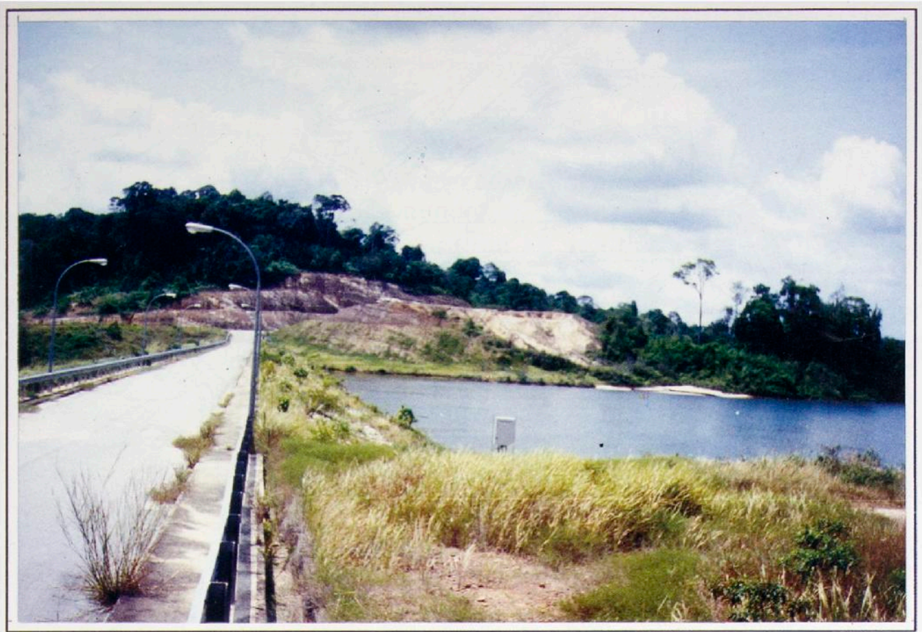
Situasi bendungan Muka Kuning
