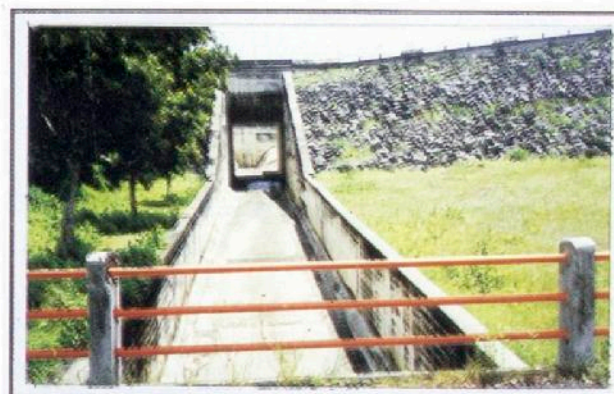
Bangunan pelimpah dilihat dari hilir
