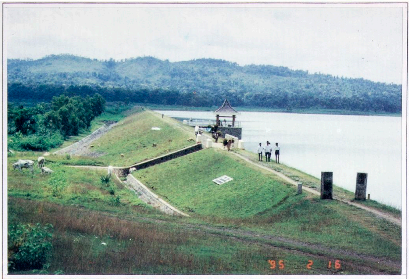
Situasi bendungan Klego
