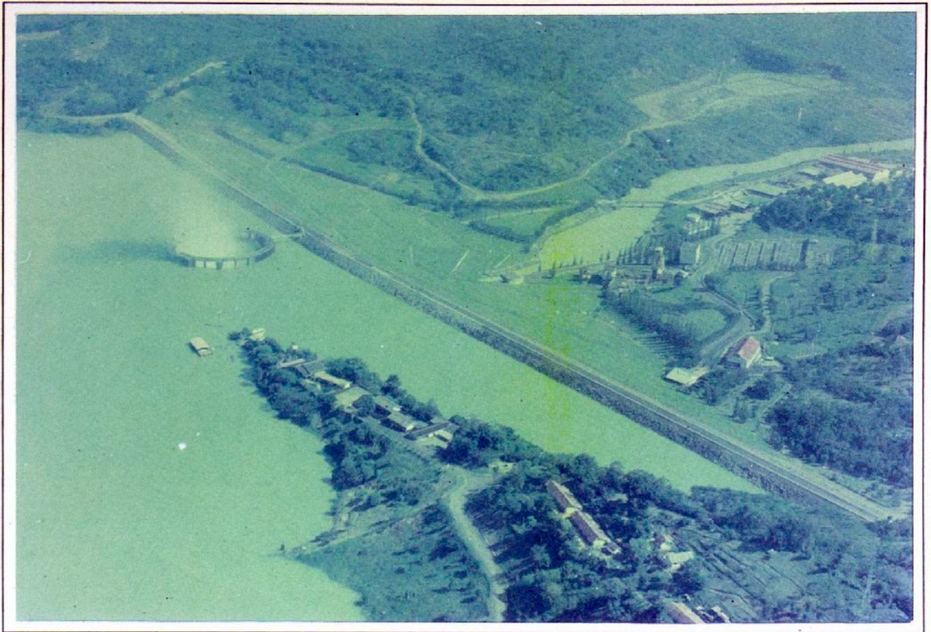
Situasi bendungan Juanda (Jatiluhur)
