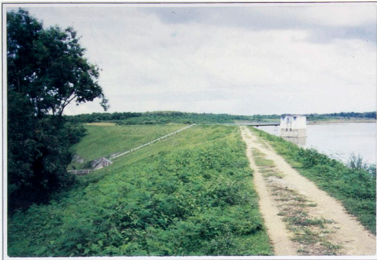
Situasi bendungan Gondang
