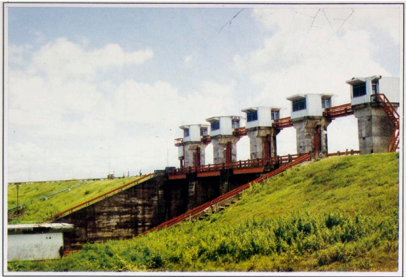
Situasi bendungan Batujai
