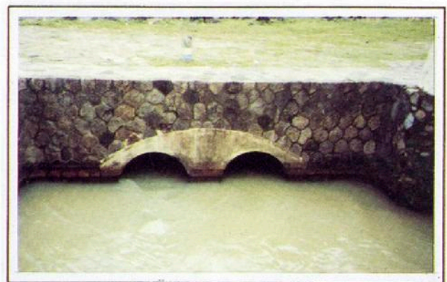
Bangunan "outlet" bagian hilir
