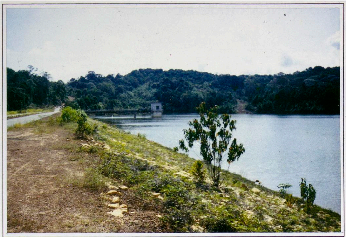
Situasi bendungan Ladi
