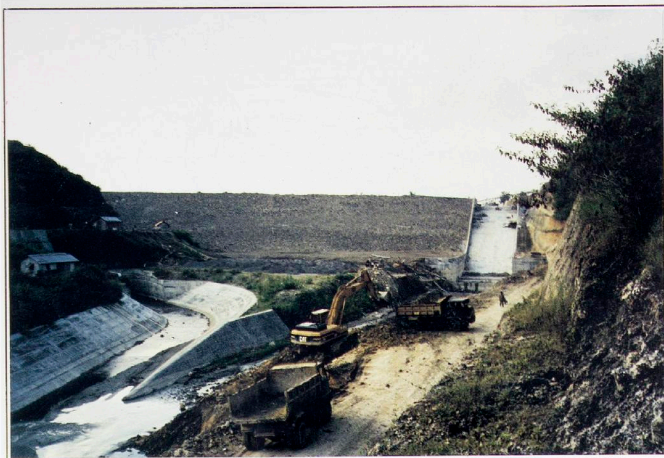
Situasi bendungan Pondok
