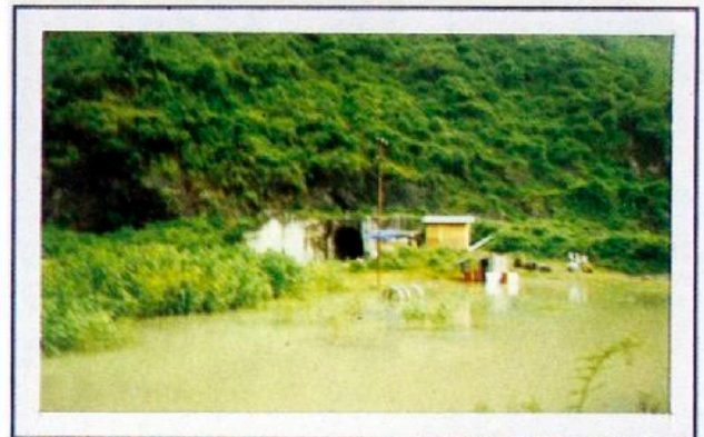
Bangunan terowong pengelak dilihat dari arah hilir
