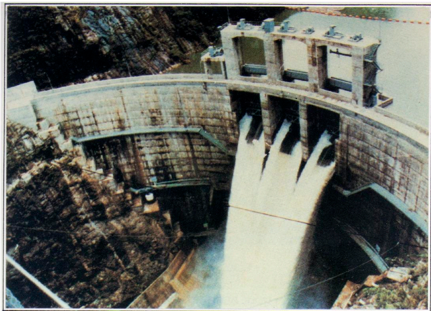
Situasi bendungan Tangga
