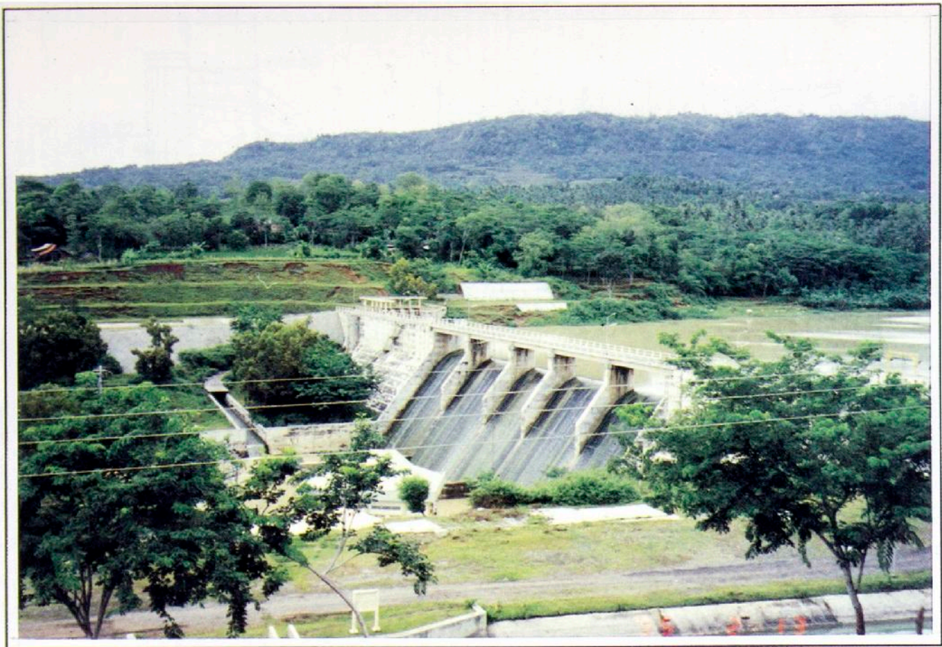
Situasi bendungan Pejengkolan
