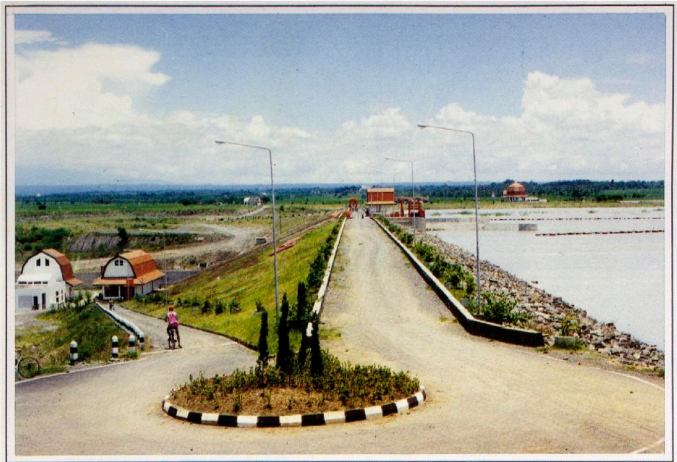
Situasi bendungan Pengga
