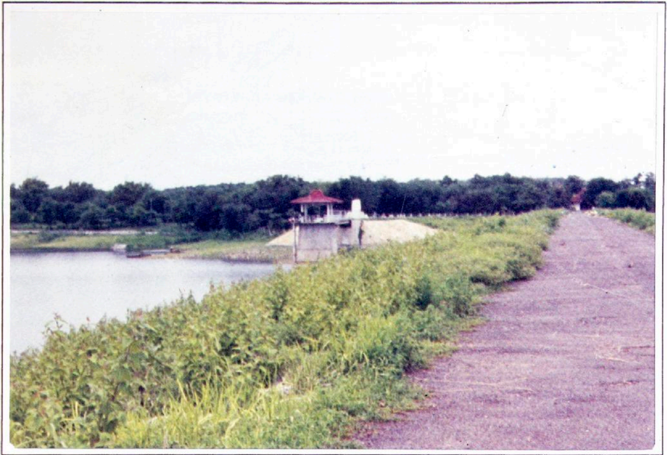
Situasi bendungan Gondang
