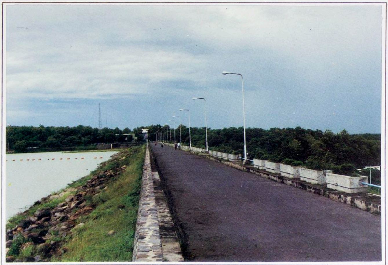
Situasi bendungan Bening ( Widas )
