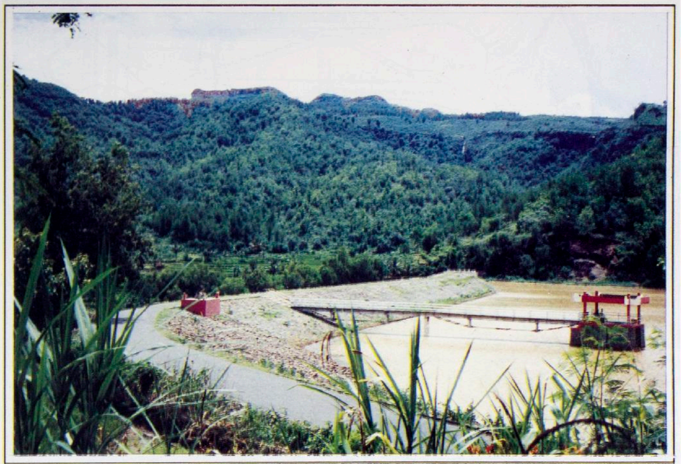
Situasi bendungan Parangjoho
