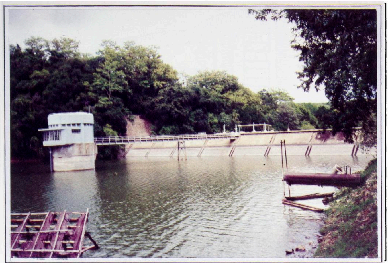
Situasi bendungan Prijetan
