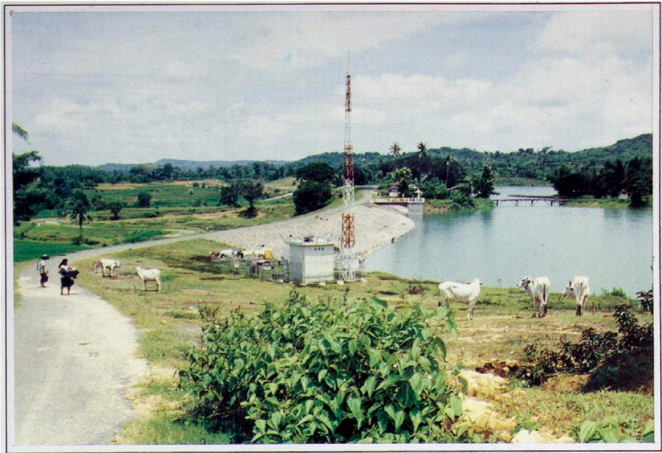
Situasi bendungan Tempuran
