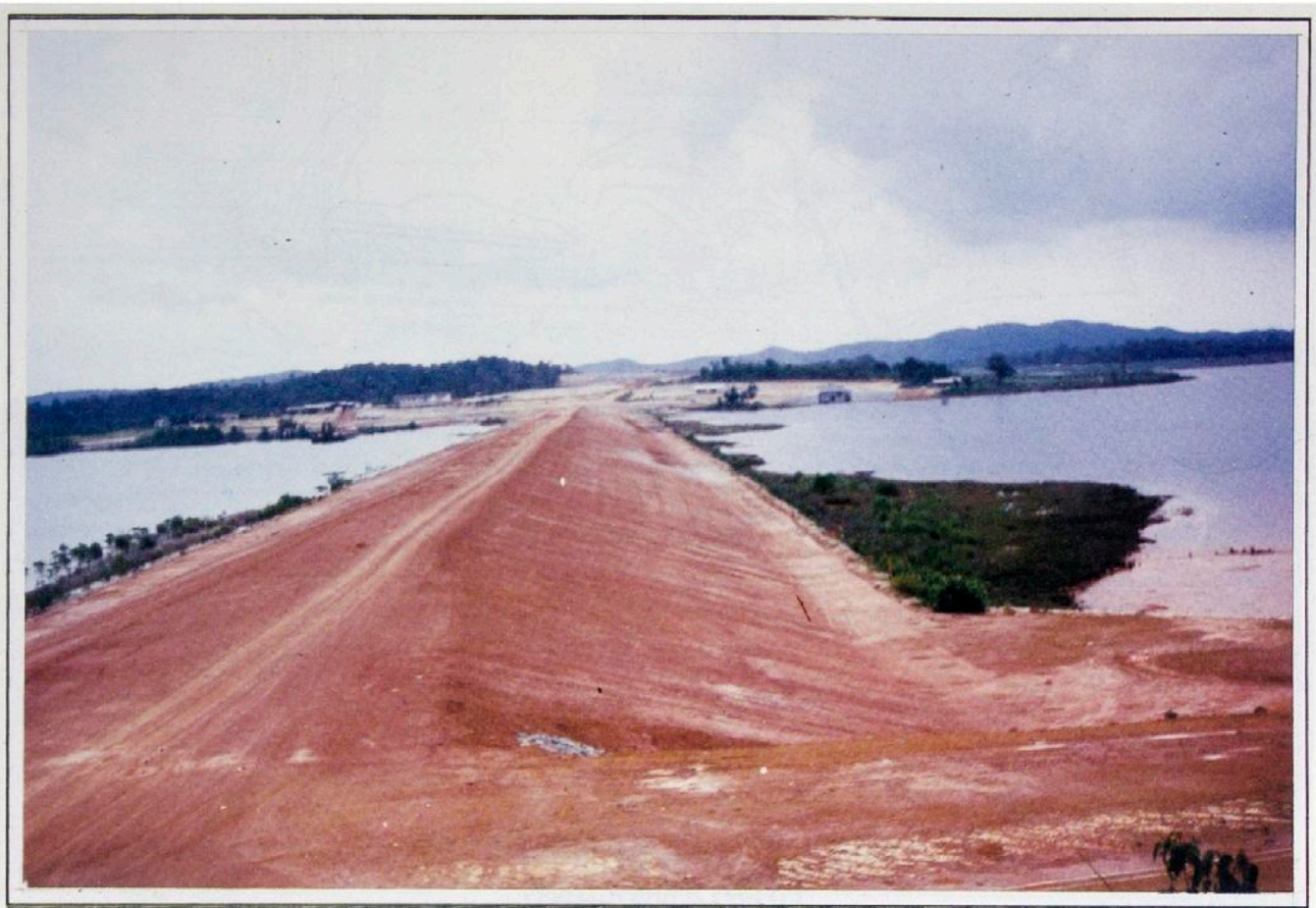
Situasi bendungan Duriangkang
