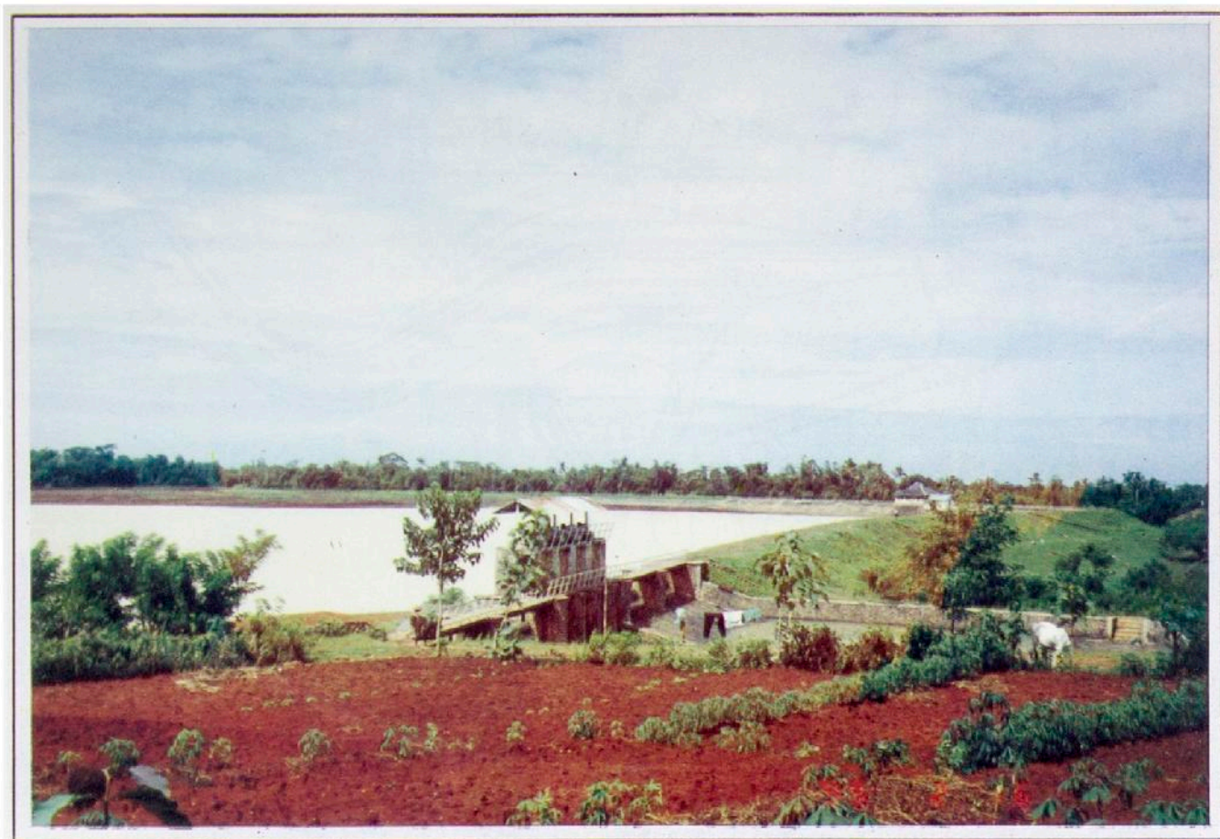
Situasi bendungan Delingan
