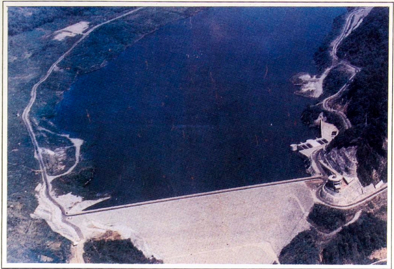
Situasi bendungan Cirata
