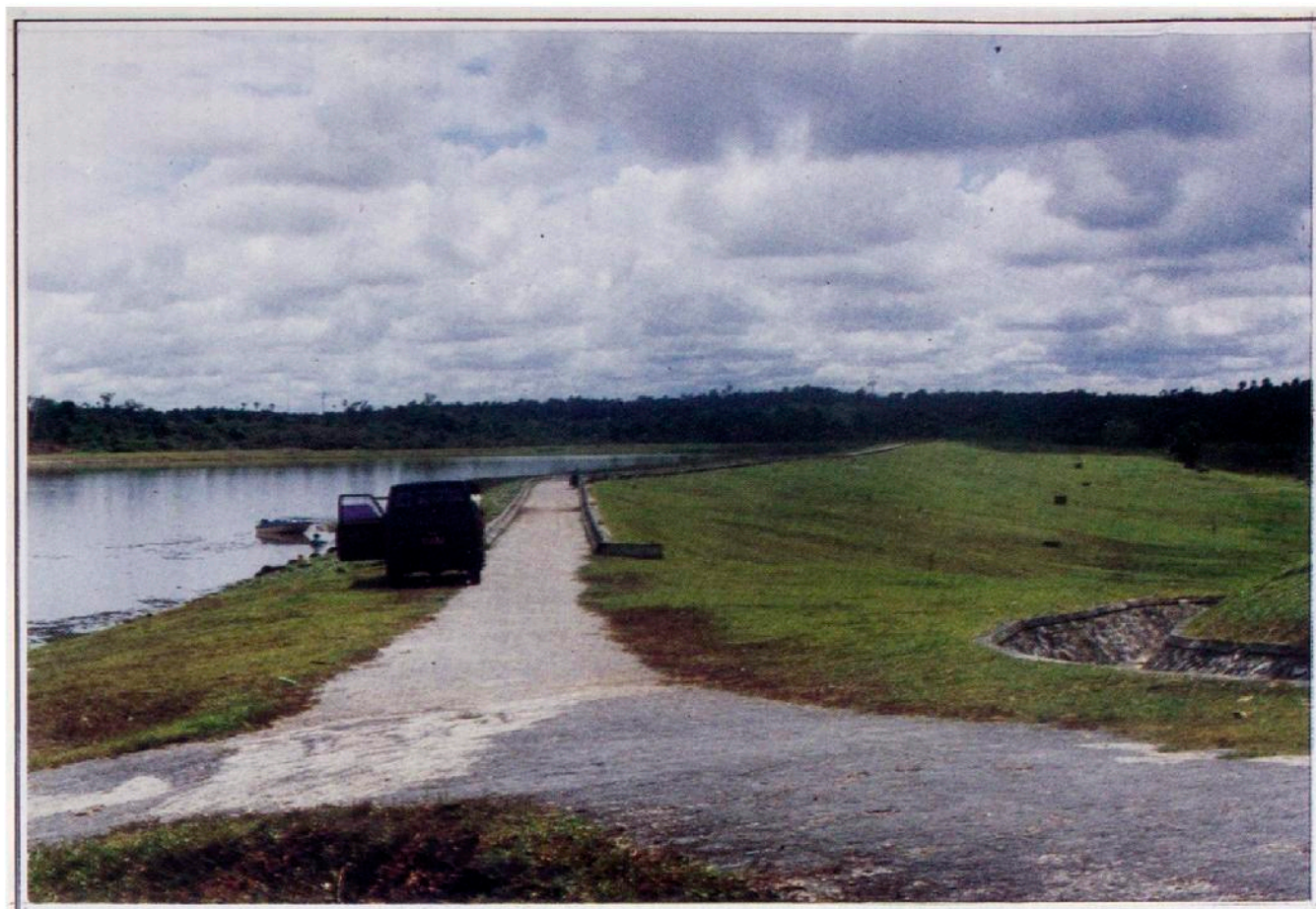
Situasi bendungan Manggar
