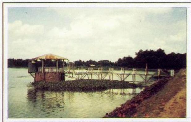
Bangunan "outlet" bagian Udik
