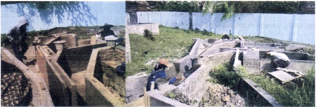
Gambar 7. Proses Pembuatan Model Fisik Bangunan Bagi Proporsional Saluran Induk Ngrambek di laboratorium Hidraulika
