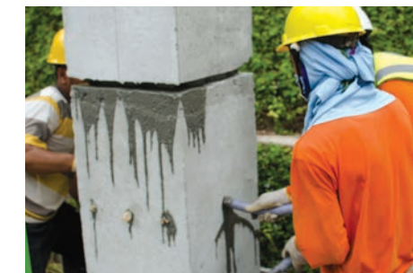
Lubang injeksi untuk merekatkan sambungan ( kemal )
