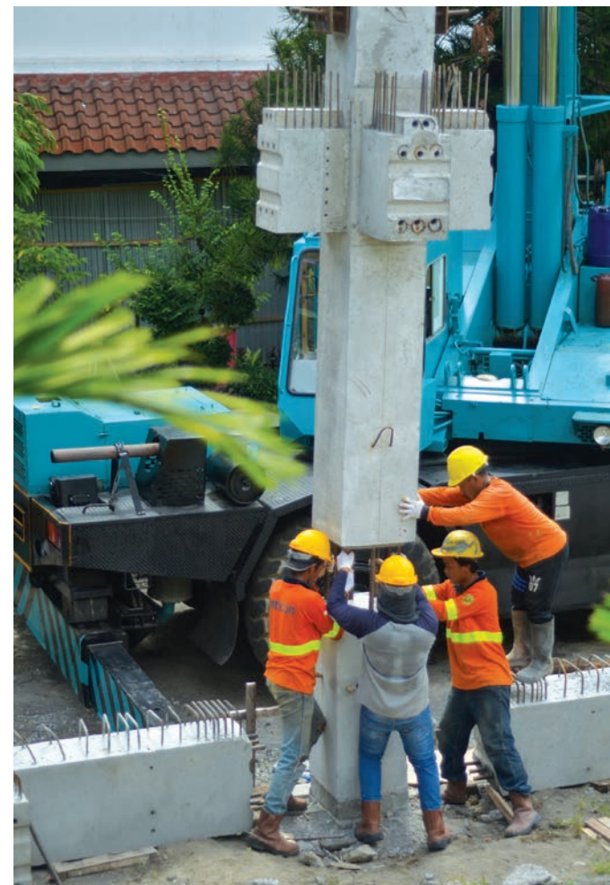
Pemasangan prekes bisa dilaksanakan secara paralel ( kemal )
