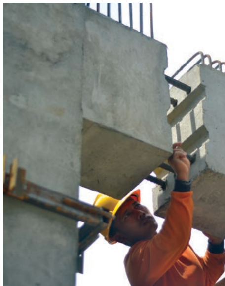
Beton Pracetak menjadi struktur bangunan (ryan)
