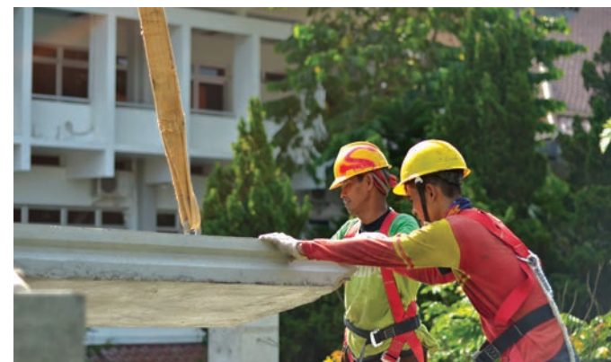
Ukuran plat lantai harus tepat agar efisien ( kemal )
