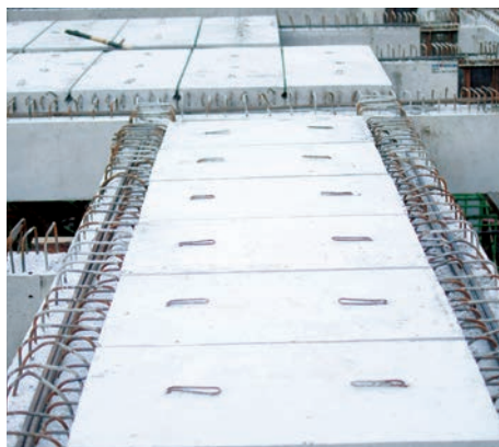
Sambungan plat lantai-balok di cor di tempat ( kemal )
