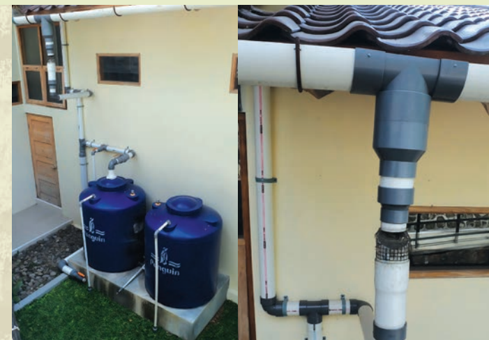
Bangunan penampung air hujan (ryan)
