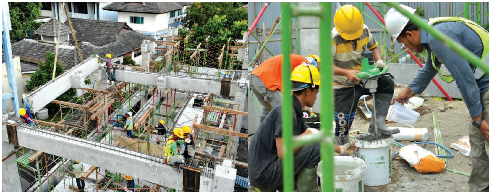
Pemasangan beton pracetak berlangsung cepat (kema)
