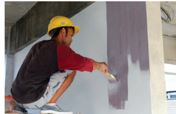
Proses cat bisa langsung dilakukan pasca erection ( ryan )
