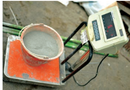
Di lapangan pengendalian campuran dengan timbangan digital ( kemal )
