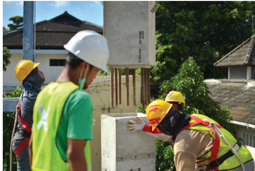
Sambungan kolom dengan kolom menggunakan besi ulir diameter 29 milimeter ( ryan )
