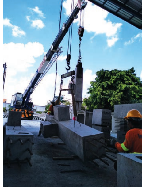
Menguji sambungan balok dan kolom (ryan)
