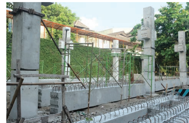
Kemungkinan panjang kolom bisa diperpanjang lebih dari satu lantai ( kemal )
