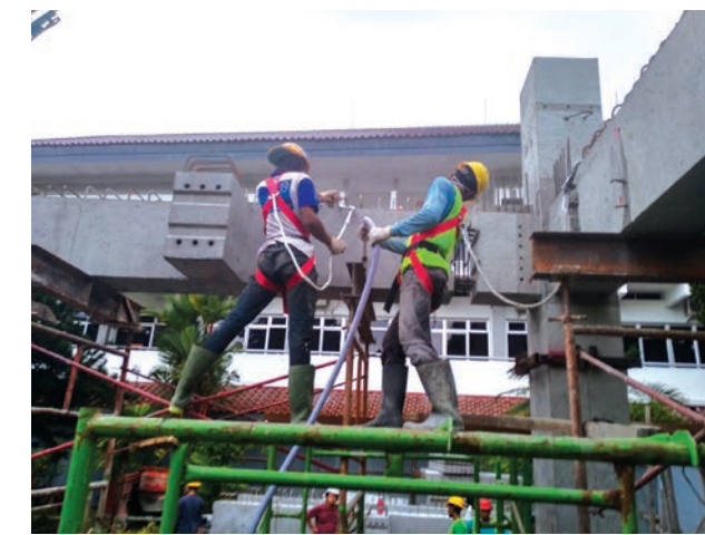
Injeksi mortar memperkuat sambungan (kema)
