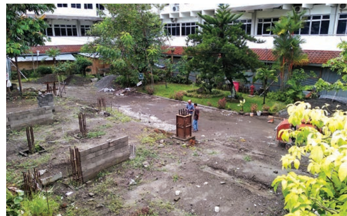
Lahan yang akan didirikan Gedung KMTS ( ryan )
