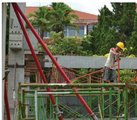
Perancah dibuka setelah injeksi beton mengalami kekuatan penuh ( kemal )
