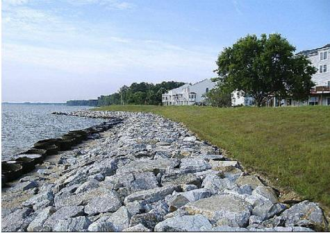
**Gambar 6.4.** (a) Contoh Penempatan Revetment
