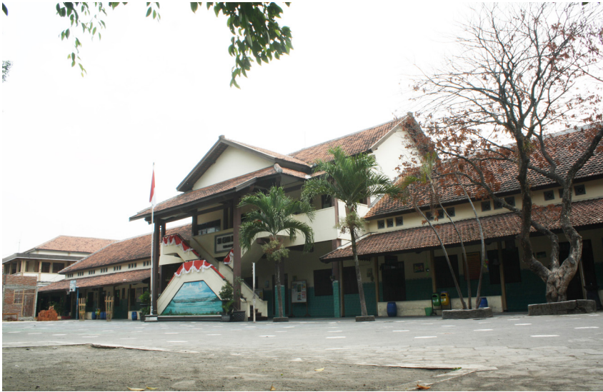
Gambar 2. Gedung SD NEGERI CEMARA DUA No.13. Bentuk bangunan sudah berubah. Foto diambil pada tanggal 17 Agustus 2015
